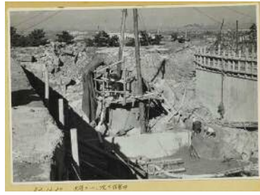
大天守北面の穴蔵石垣の大半がはずされている
