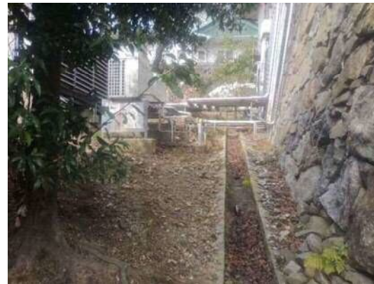
小守南西隅から見上げる
