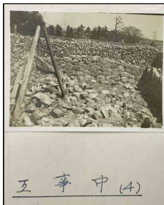
図4 昭和27年からの石垣積み直し状況写真
