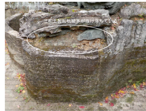
三和土製乱杭擬木修理箇所(例)
