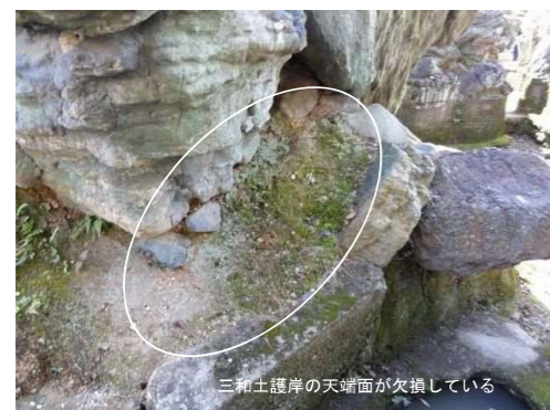
三和土護岸天端修理箇所(例)
