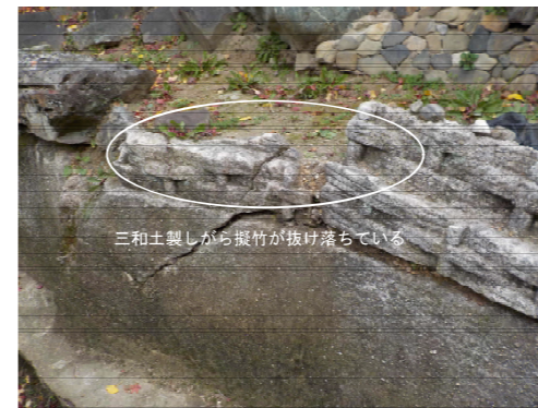
三和土製しがら擬竹修理箇所(例)
