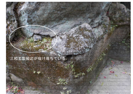
三和土製擬岩修理箇所(例)
