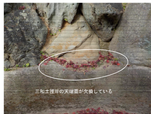
三和土護岸天端修理箇所(例)
