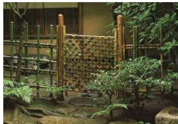
写真 2-1 サビ丸太支柱の例
