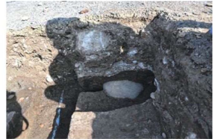
T13 北壁根固め石？（西から）
