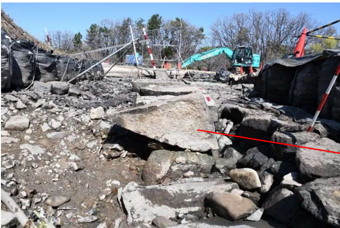
図6 001-2856 仮置き状況（南から）
