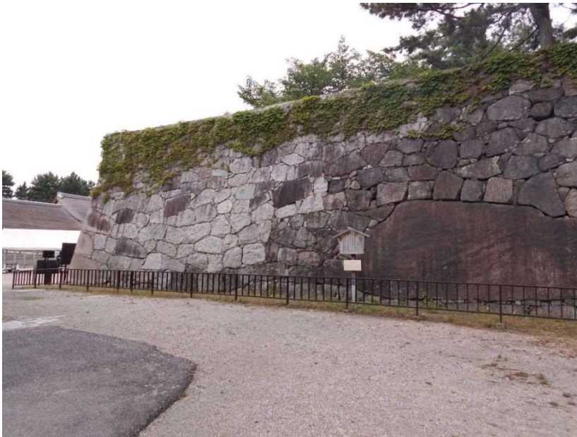
写真1 東一之門跡(西側)石垣(東から)(白っぽく見えるのが新補石材)
