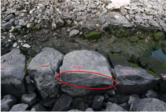
図8 001-5054 前面のゲンノウによるはつり（赤丸内）（東から）
