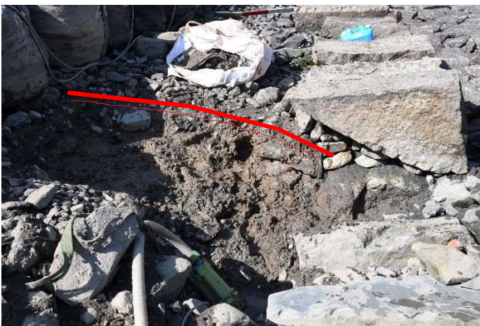
図3 001-2856 背面堆積状況（赤い線より上がへドロ状堆積、下が黄褐色粘質土）（南から）
