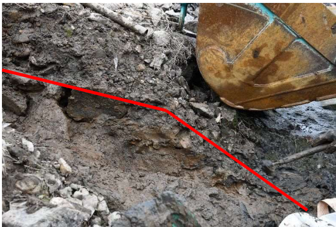
図7 001-5054背面堆積状況(赤い線より上がへドロ状堆積、下が黄褐色粘質土)(南から)
