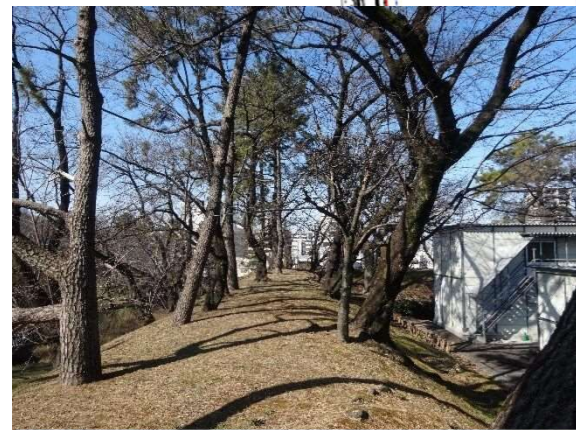
写真【西之丸】南側石垣上部の状況
