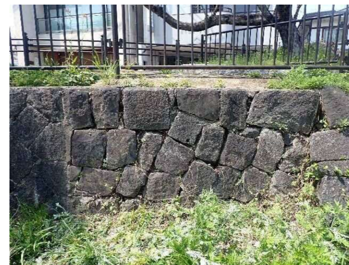
図 9 現存する辰之口南側の石垣
