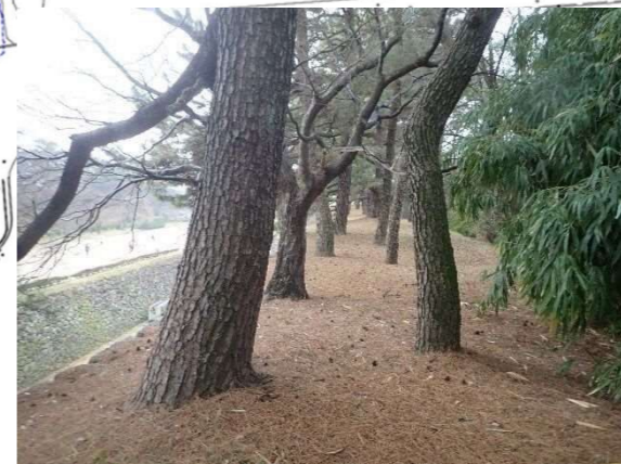
写真【本丸】南側石垣上部の状況
