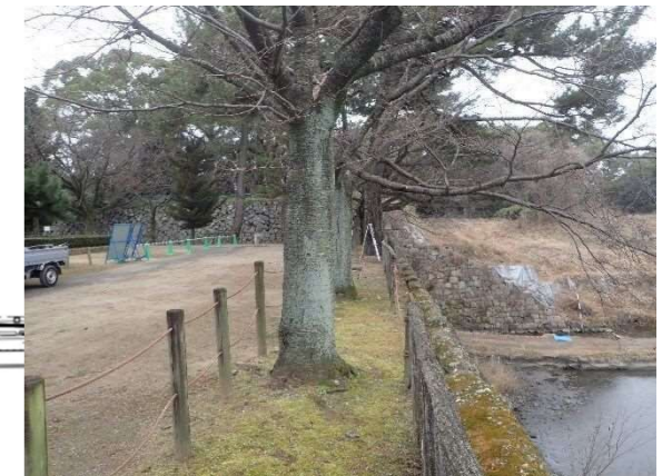
写真【二之丸(北)】南蛮練塀付近の状況
