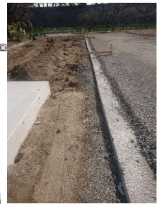
②学芸員の立会いなく、掘削と基礎施工が行われていたもの (2/21~2/25頃)
