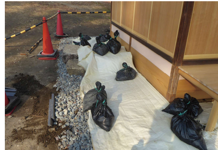
写真 5-1 熨斗瓦設置状況
