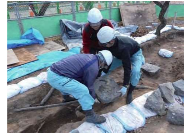
写真2 修復作業風景
