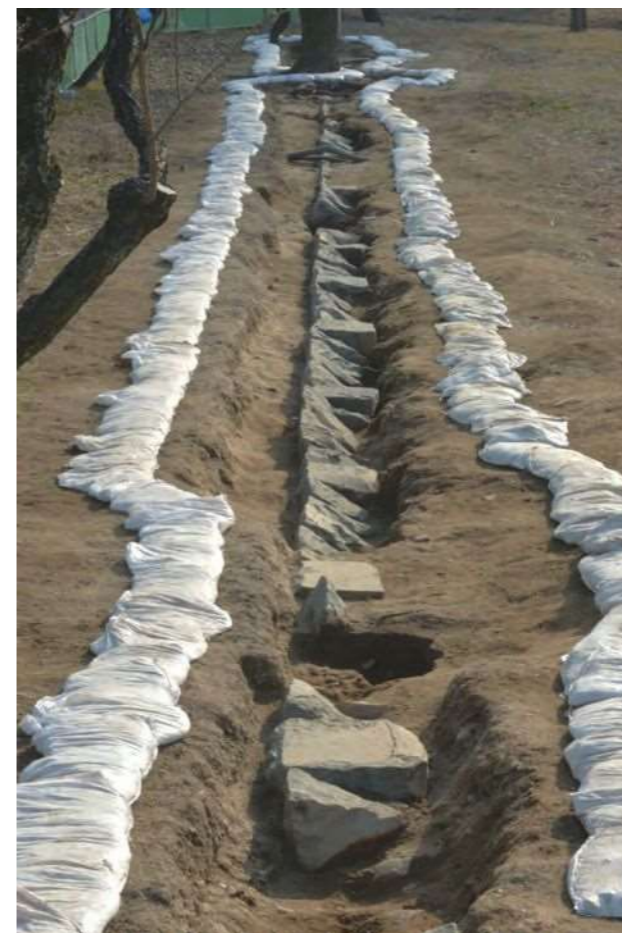
写真5 修復全景（北から）
