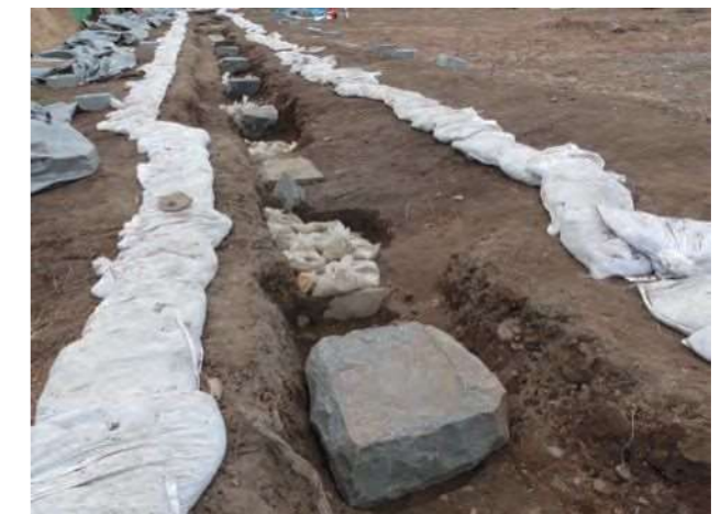
写真4 礎石の設置状況（北東から）
