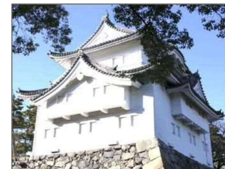
東南隅櫓（重要文化財）
