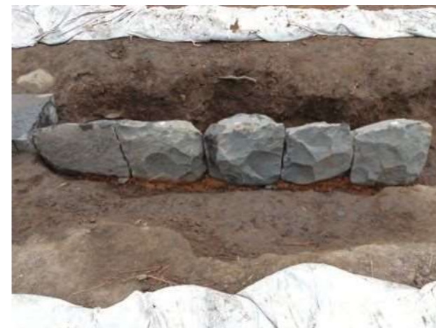
写真3 鋼土による高さの調節（東から）
