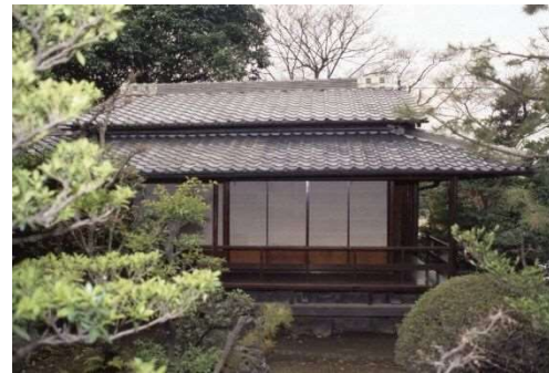
余芳亭東側外観（昭和61年撮影） (名古屋市文化財保護室所蔵)
