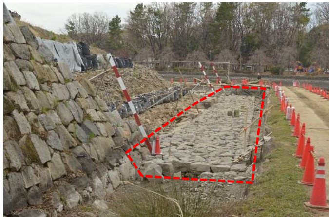
写真2 根石部の安定化（枠工）
