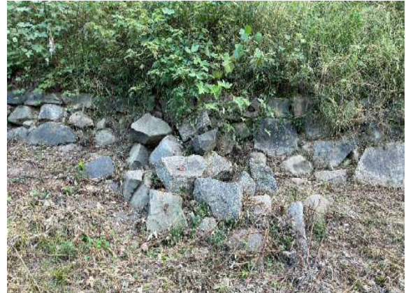
写真 4-3-2 過去の石垣修復等により集積された石材
