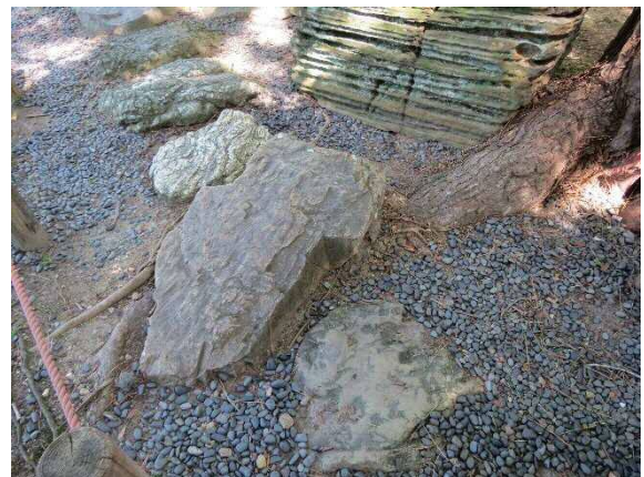
写真 3-2-5 根に持ち上げられていた飛石（近代前庭） ※安全確保のため令和年度に園路脇に仮移設
