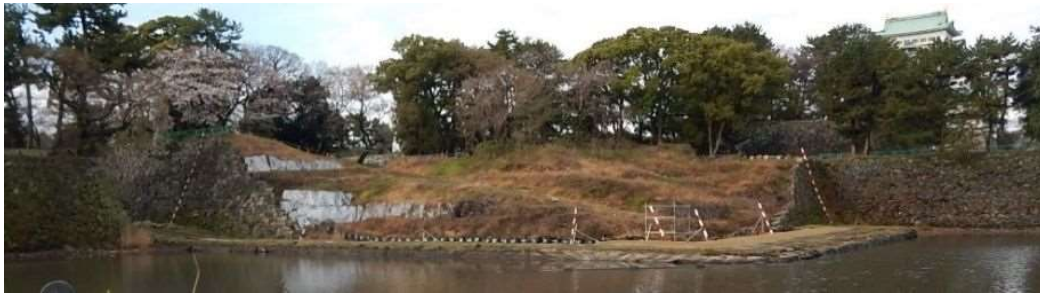
写真1 解体完了写真
