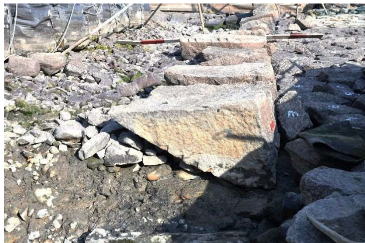
写真3 慶長と天和の接点の逆石状石材
