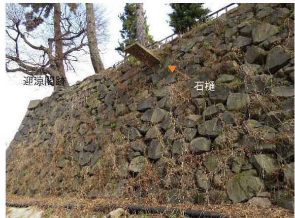
写真 3-2-6 使われていない石垣北西部の石樋
