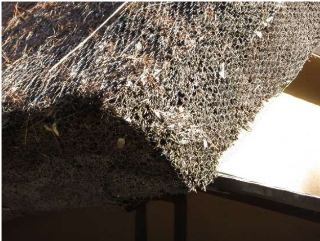
写真6 ネット工法の事例（拡大）
