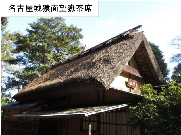
写真5 ネット工法の事例 （平成 30 年度（2018）設置）
