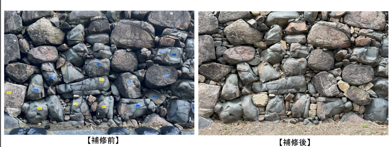
図 6 石垣 U65 の被熱劣化が激しい範囲の亀裂補修状況
