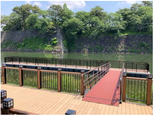
写真③ 浮棧橋
