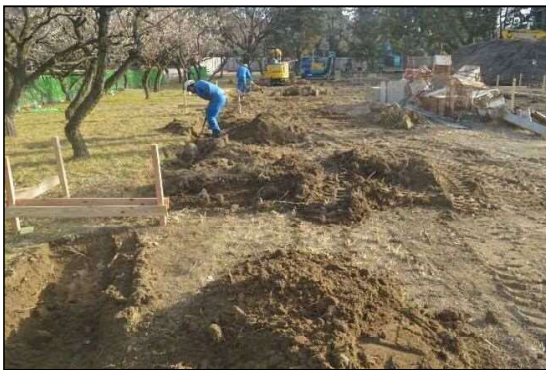
写真2 現場状況／北から
