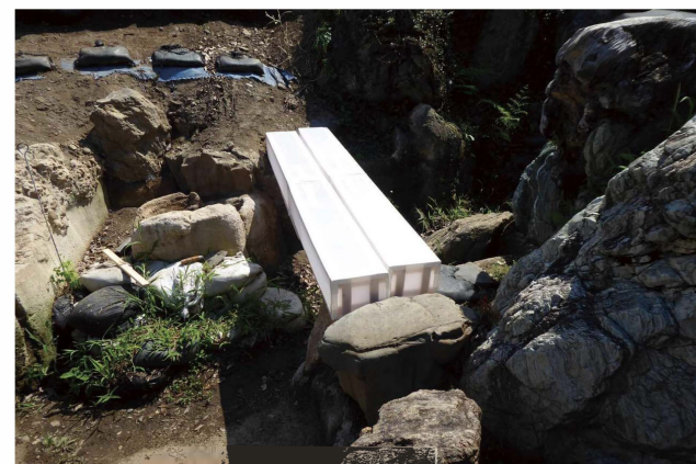
写真2-2 実寸模型設置状況(上空より)
