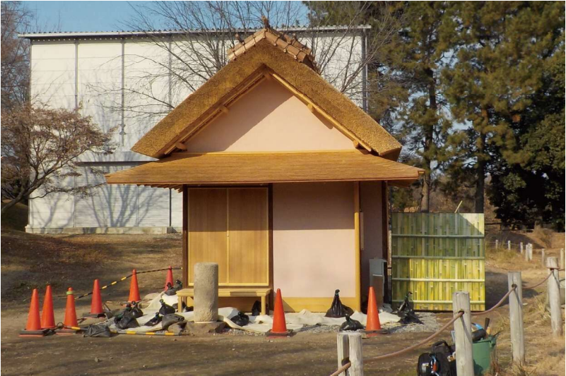
写真7-5 袖垣（東側）実寸模型設置状況（角度0度） （南側より）
