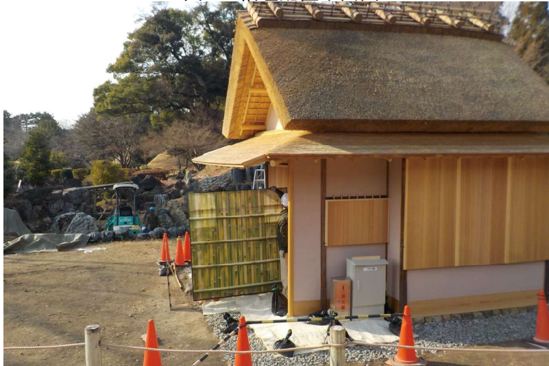
写真7-4 袖垣（南側）実寸模型設置状況 （東側より）
