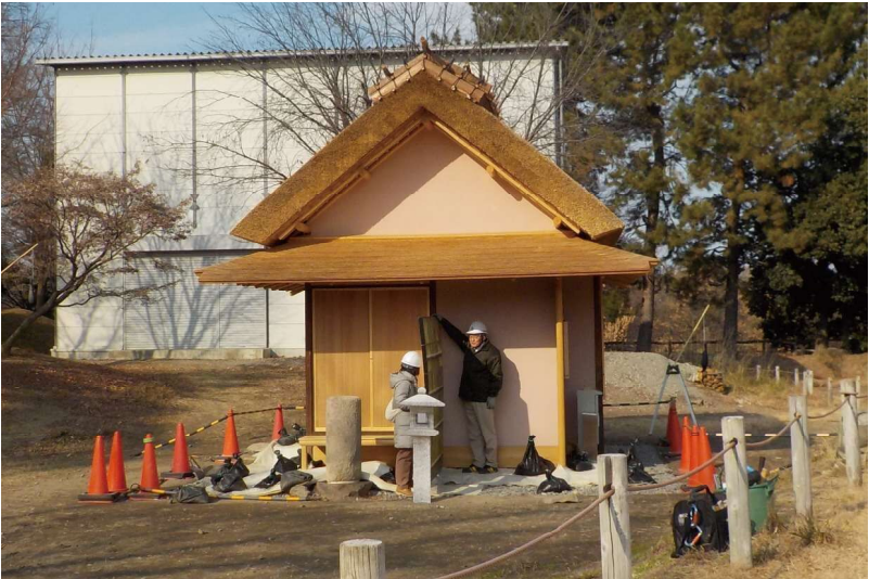
写真7-3 袖垣（南側）実寸模型設置状況 （南側より）
