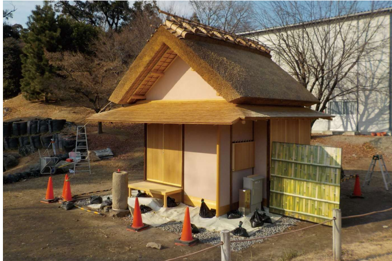
写真7-6 袖垣（東側）実寸模型設置状況（角度0度） （南東側より）
