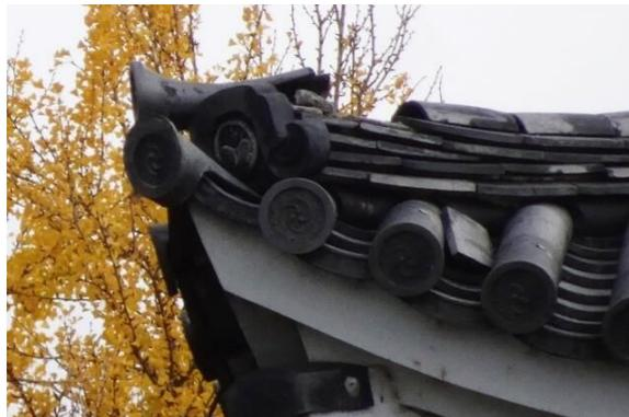
写真 2-6【西北隅櫓 (A03)】瓦の脱落
