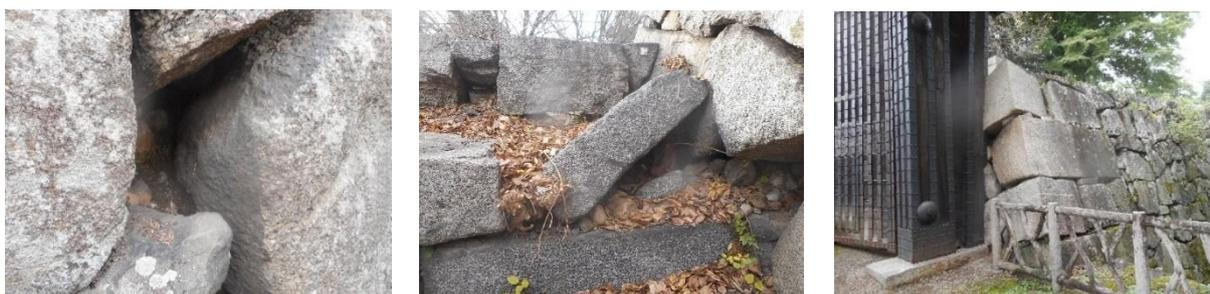
写真 3-13 大手二之門北側の膨らみ 写真 3-14 大手二之門北側の雁木倒壊 写真 3-15 東二之門北側の築石傾斜
