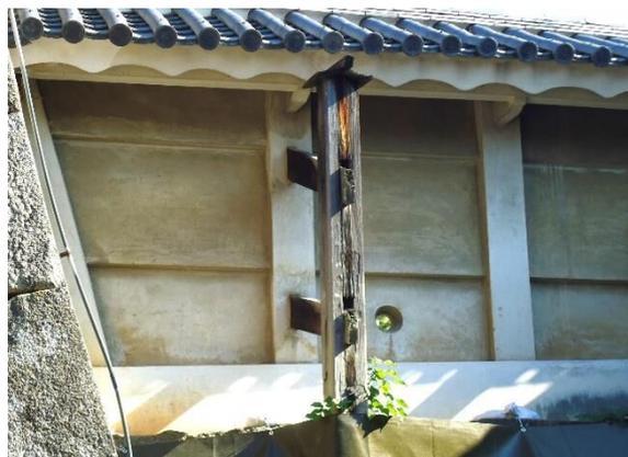
写真 2-10【表二の門附属土塀 (A04')】控え柱腐朽
