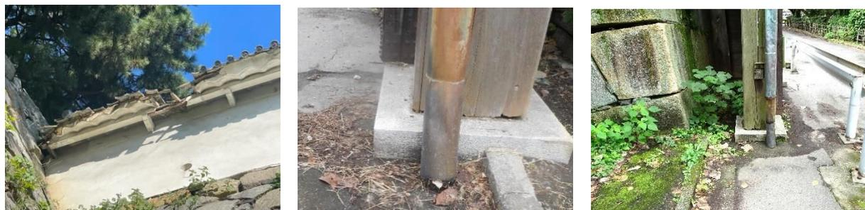
写真 3-7 表二の門附属土塀屋根の破損 写真 3-8 大手二之門の樋詰まり 写真 3-9 大手二之門の排水路堆積
