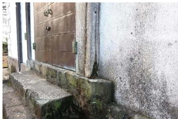
写真 2-16【乃木倉庫 (B01)】付柱腐朽、凝灰岩剥離
