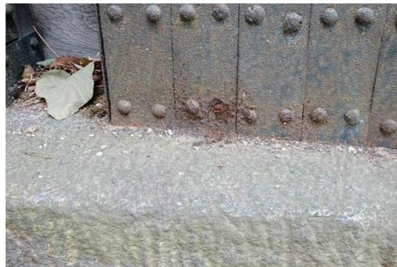
写真 2-14【旧二之丸東二之門 (A04)】鋸の欠損
