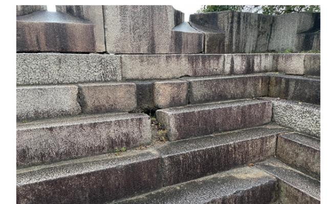
図 5 江戸城田安門 (控柱の据わる段が異なる) 図 6 大坂城玉造門 (控柱に合わせて 2 段分掘り込む)
