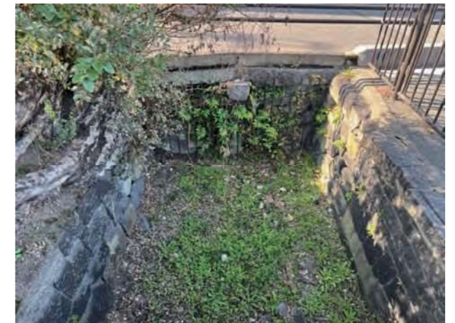
図4 辰之口水道の排水部分（東から）
