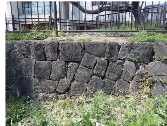
図9 現存する辰之口南側の石垣
