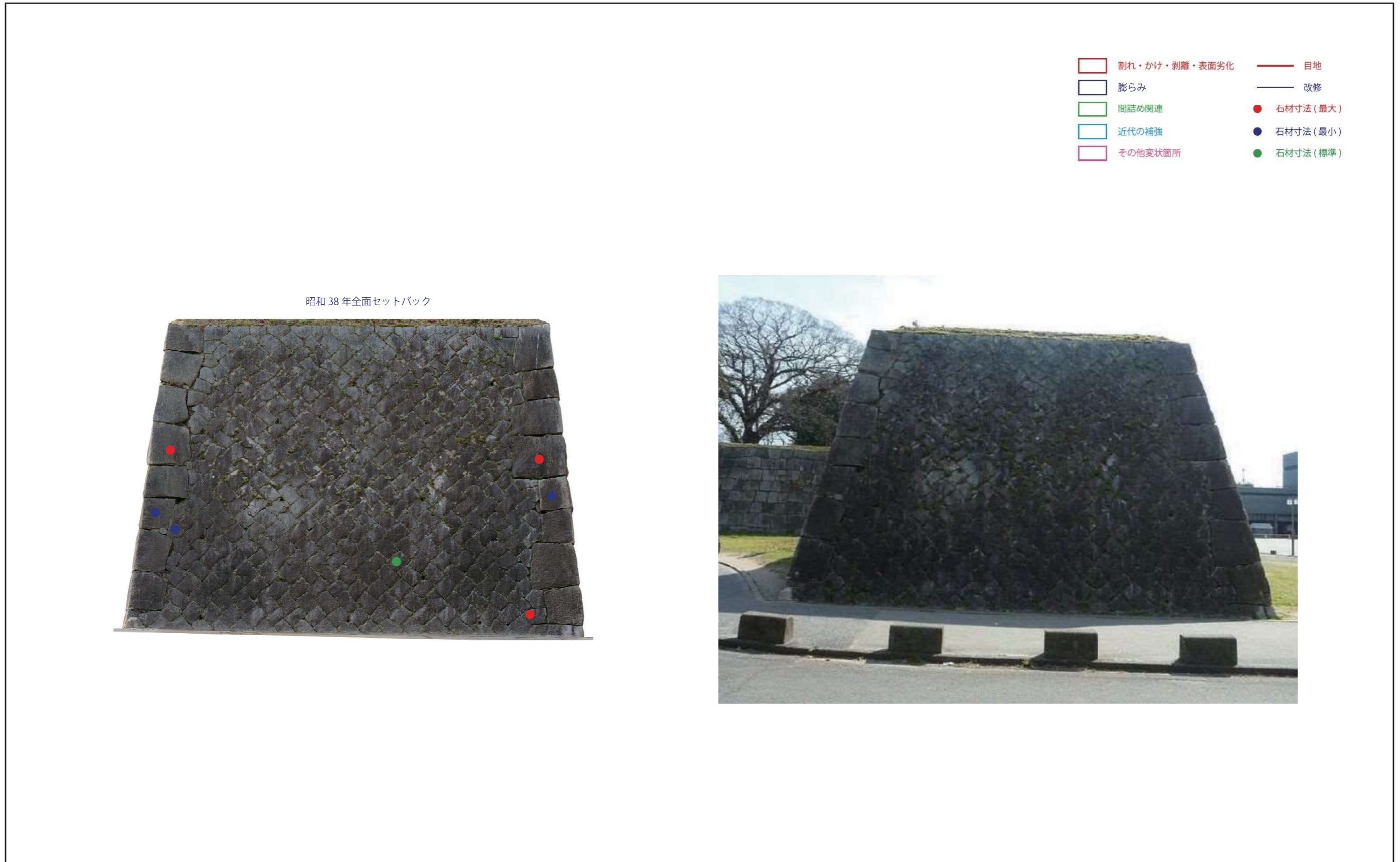
図 13 ウ-(イ) 後世の造作による石垣面の改変(二之丸 201N 石垣)
