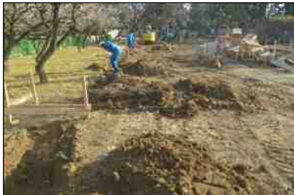
写真2 現場状況／北から
