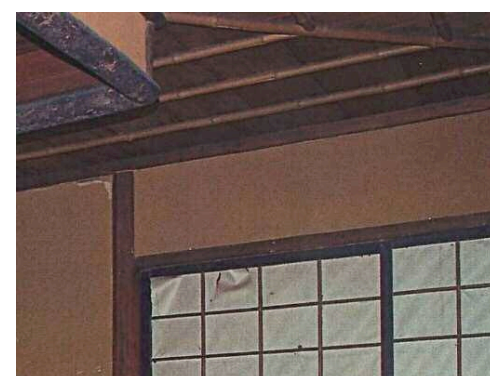
下座の天井 (室内より見る)
