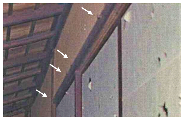
4枚引違い部分の鴨居（折釘が打たれている）
