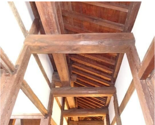
図 22 2 階東入側 （繋梁と上部の3階柱盤）
