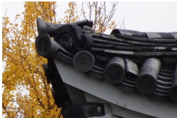
写真 2-6【西北隅櫓（A03）】瓦の脱落
