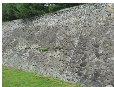
写真 3-10 西南隅櫓西側石垣の膨らみ
