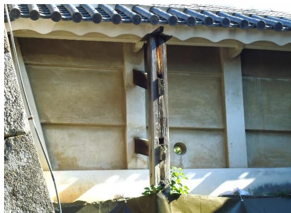
写真 2-10【表二の門附属土塼（A04'）】控え柱腐朽
