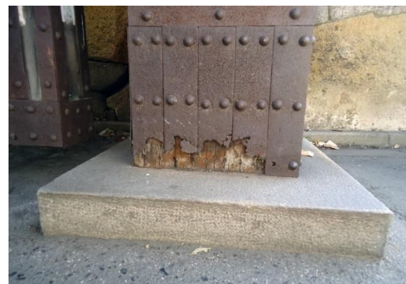
写真 2-12【二之丸大手二之門（A04）】金属腐食
