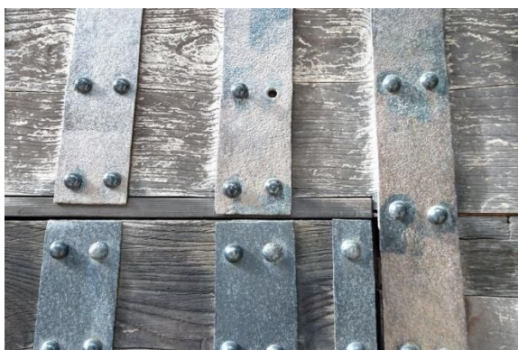
写真 2-13【旧二之丸東二之門（A04）】鋸の欠損
