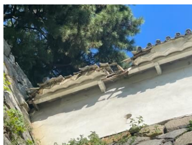
写真 3-7 表二の門附属土塀屋根の破損 写真 3-8 大手二之門の樋詰まり 写真 3-9 大手二之門の排水路堆積
