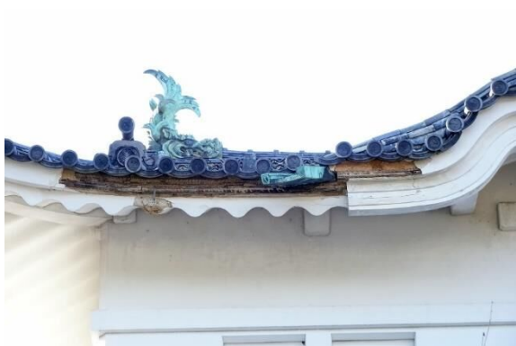
写真 2-3【東南隅櫓（A02）】漆喰、塗土剥離
