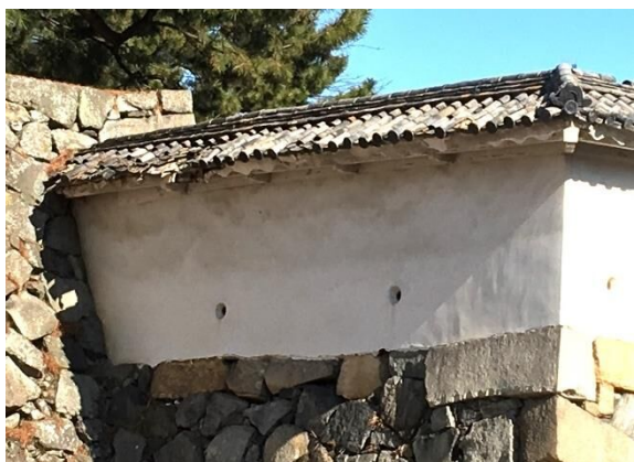
写真 2-9【表二の門附属土塼（A04'）】屋根瓦欠失
