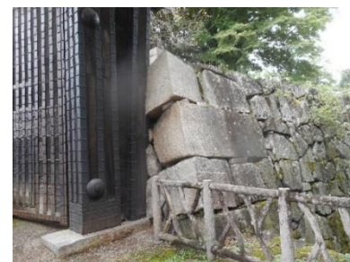
写真 3-15 東二之門北側の築石傾斜
