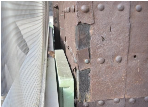
写真 2-8【表二の門（A04）】金属腐食
