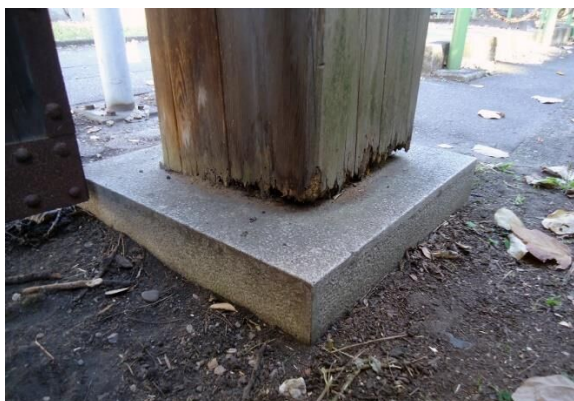
写真 2-11【二之丸大手二之門（A04）】柱脚腐朽
