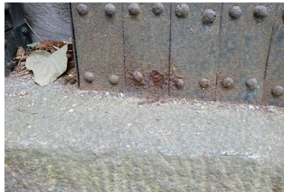
写真 2-14【旧二之丸東二之門（A04）】鋸の欠損
