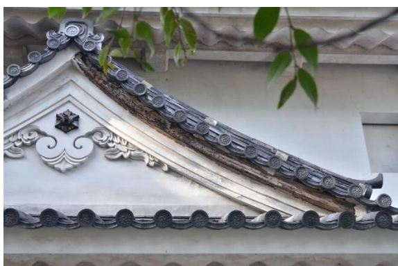
写真 2-5【西北隅櫓（A03）】漆喰、塗土剥離
