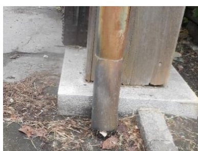
写真 3-7 表二の門附属土塀屋根の破損 写真 3-8 大手二之門の樋詰まり 写真 3-9 大手二之門の排水路堆積
