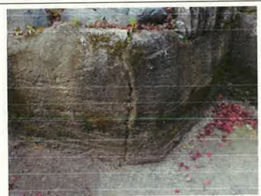
三和土護岸目地修理箇所(例)
