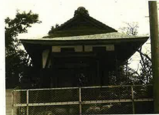
風信亭西側外観(昭和48年頃)
