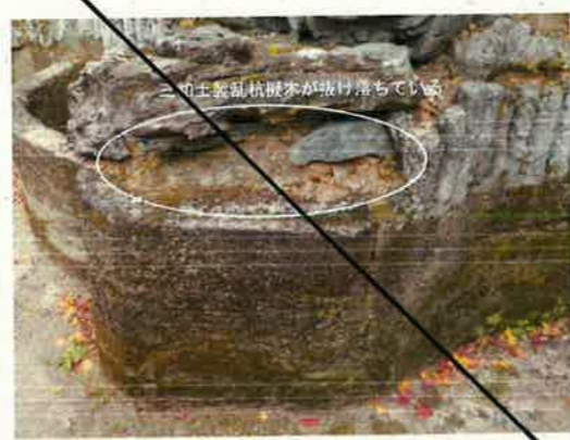
三和土製乱杭擬木修理箇所(例)
