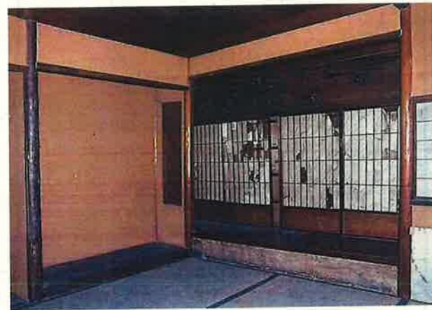
写真① 余芳亭 内部 (平成23年度解体前写真)
