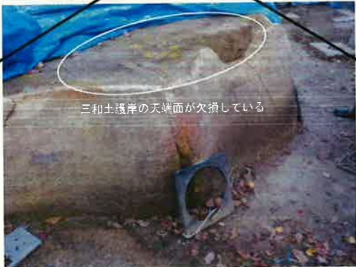
三和土護岸天端修理箇所(例)
