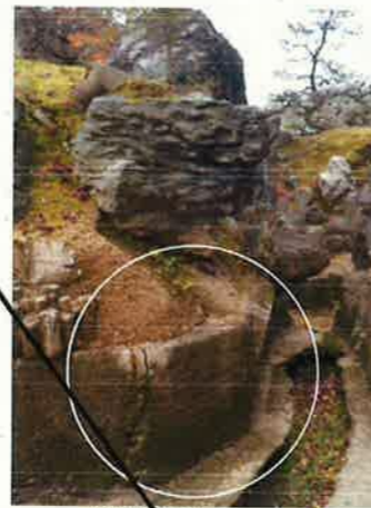
三和土護岸傾倒部(東面)
