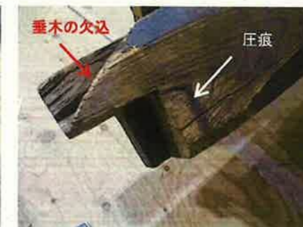
三通り小屋梁の仕口(北面)
