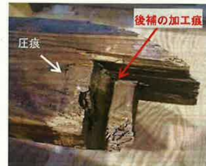
四通り小屋梁の仕口(南面)
