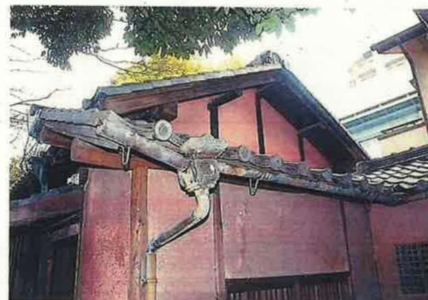
写真② 余芳亭 外部 (平成23年度解体前状況)
