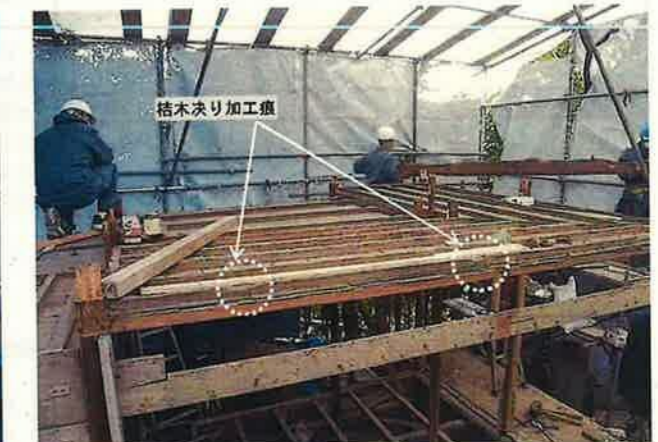
写真④ 天井材解体状況（H23年度） 天井材は当初材が残存していた。廻縁上の銅縁材天端に、使用していない枯木決りの痕跡があった。
