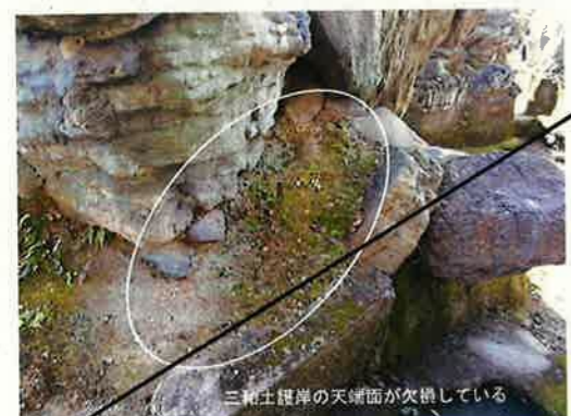
三和土護岸天端修理箇所(例)
