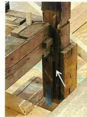
(へ五柱北面) 腰幅木の痕跡
