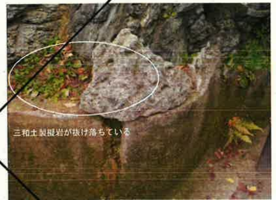
三和土製巖岩修理箇所(例)
