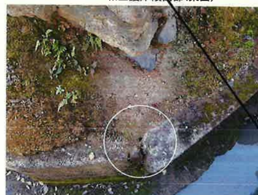
三和土護岸傾倒部(上面)
