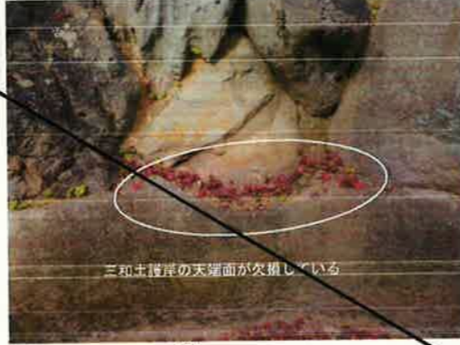
三和土護岸天端修理箇所(例)
