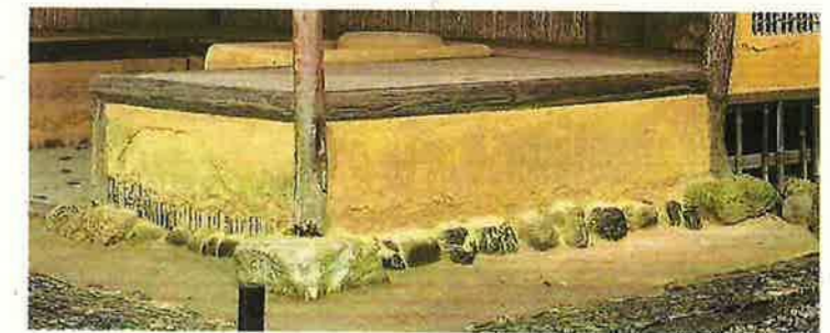
図4-1-7(類例) 桂離宮賞花亭の足元を見る 写真『桂離宮』(小学館発行)より転載 大振りの礎石が据えられている。桂離宮では他の建物も礎石には大振りの石が使われている。
