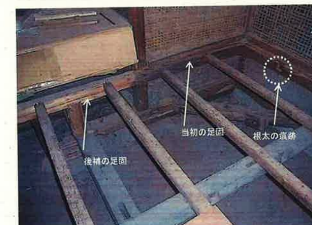
写真⑤ 床組の解体状況（H23年度） 足固めは、付書院部分のみ後補材で、他は当初材が残っていた。当初材の足固めに不要の根太の痕跡があった。
