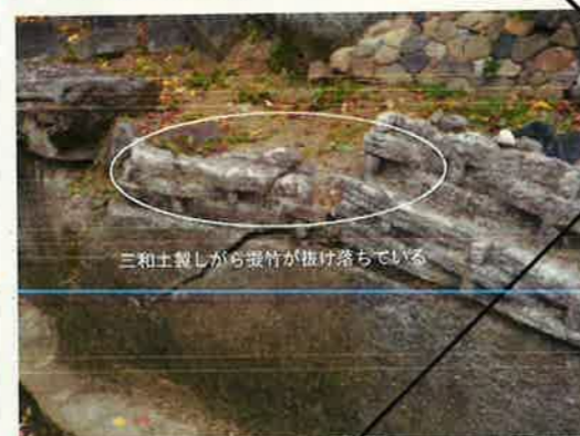
三和土製しがら製竹修理箇所(例)
