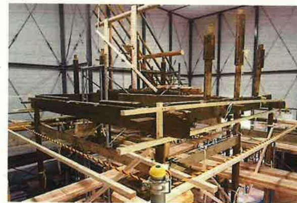
仮組状況③
