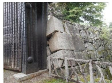
写真 3-13 大手二之門北側の膨らみ 写真 3-14 大手二之門北側の雁木倒壊 写真 3-15 東二之門北側の築石傾斜
