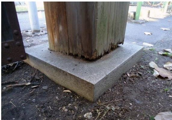
写真 2-11【二之丸大手二之門（A04）】柱脚腐朽
