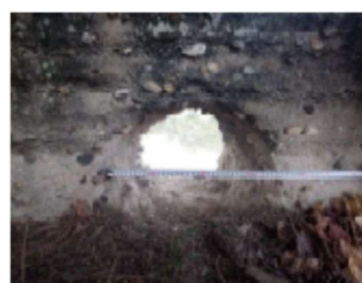
写真2 狭間部(南側より)
