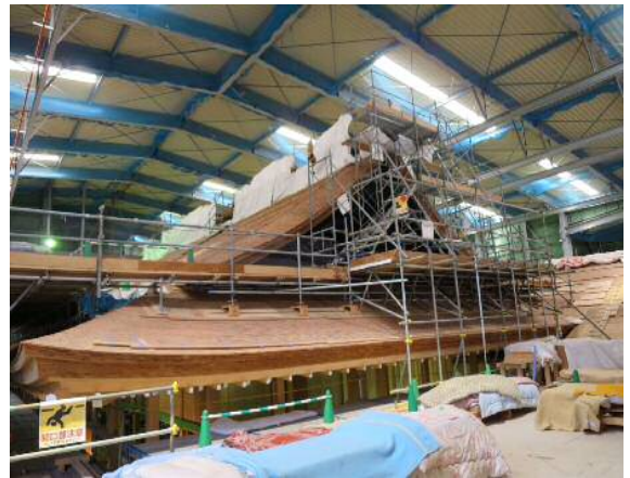
②[上洛殿] 屋根状況 (東より臨む) [H29. 8]
