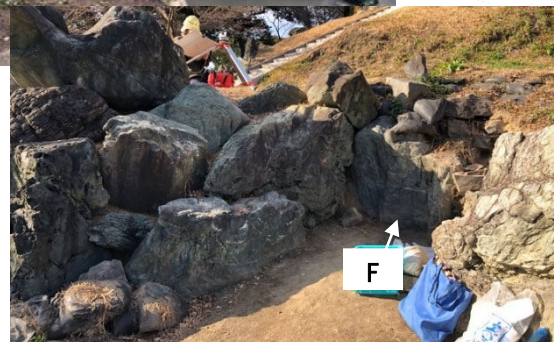
写真3 現況写真（F 近景）
