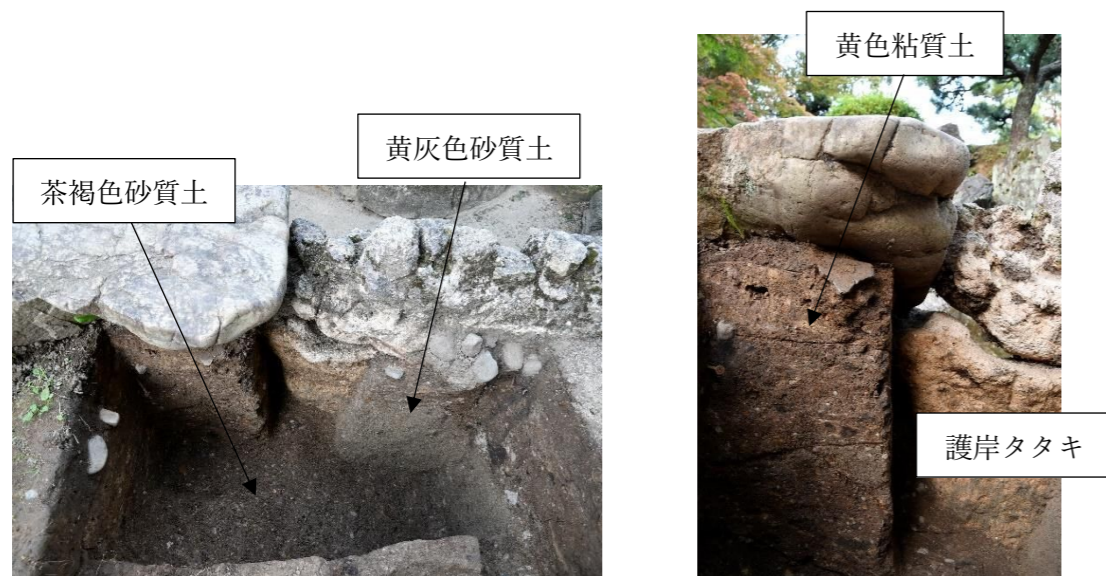
【写真 12】護岸背面(西より) 【写真 13】景石・護岸・擬木背面(西より)
