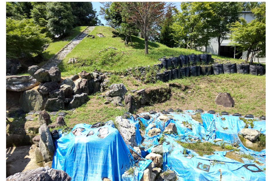
写真1 現況写真（南から撮影）
