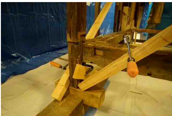
北東角 敷居ほぞ穴
