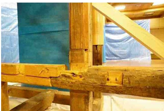
北側足固の新旧と枠痕跡
