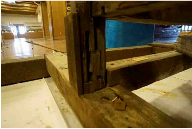
南東角 腰板の痕跡
