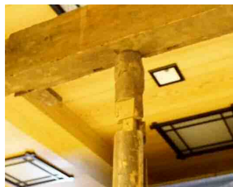
柱頭部の切欠き
