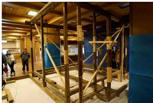
仮組 全景 北東から
