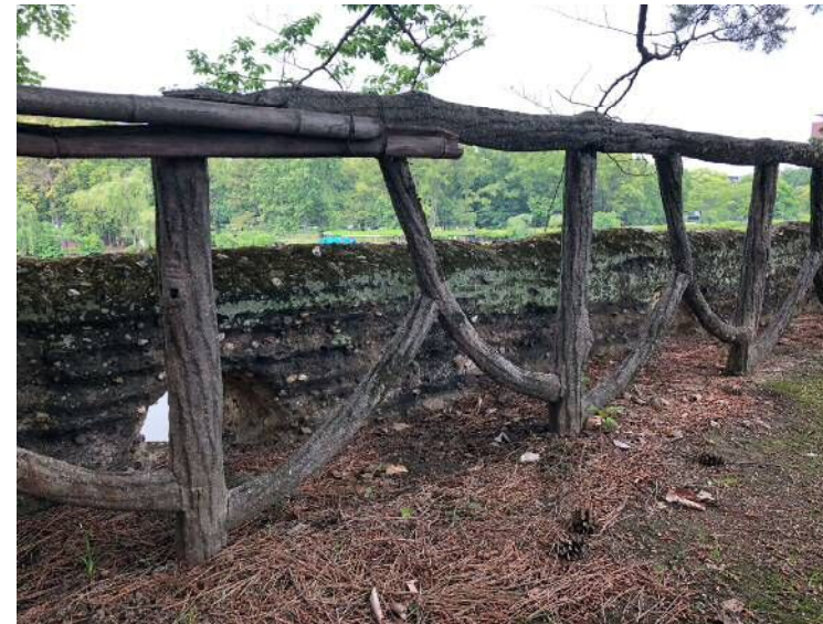
写真 1-2 南蛮練塀（近景 南西側から撮影）
