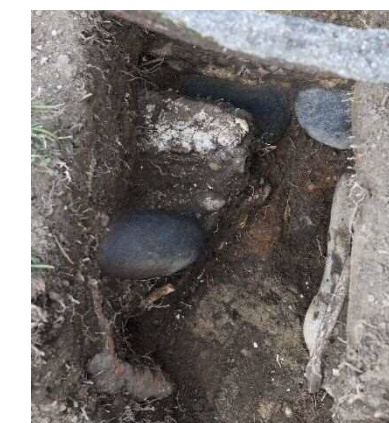
図 3-7 T2 練堀下の状況拡大(南から)
