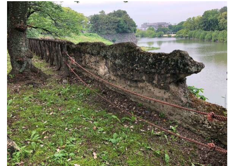
写真 1-3 南蛮練塀（近景 南東側から撮影）
