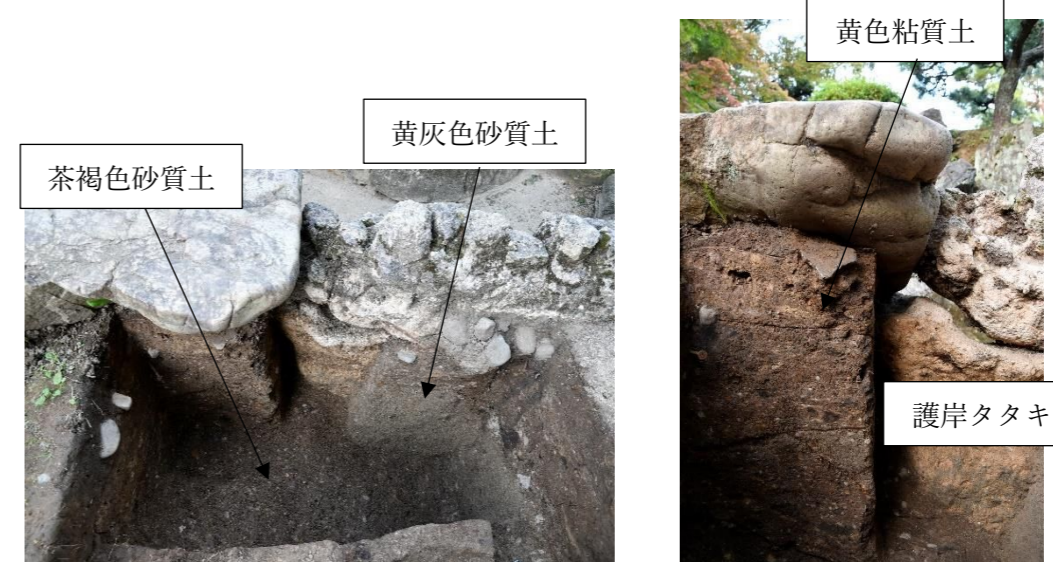
【写真1】 護岸背面(西より)
