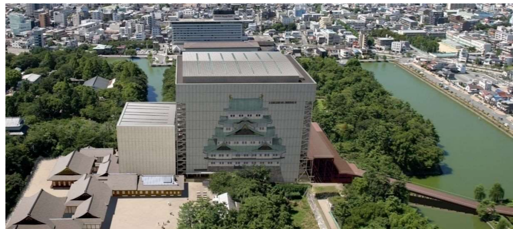
図-7.1.14 素屋根置完了イメージパース
