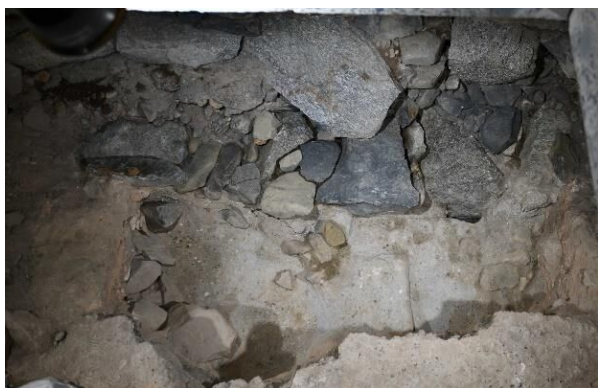
図 15 BA05 (大天守穴蔵石垣北面) 根石付近の状況
