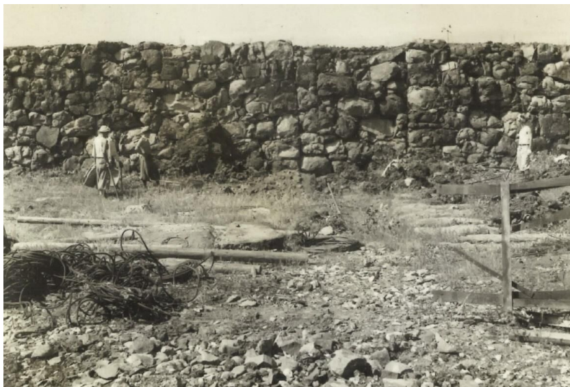
大天守西面の「切り欠き」の痕跡。創建期に存在したものを宝暦の修理の際に復元している。
