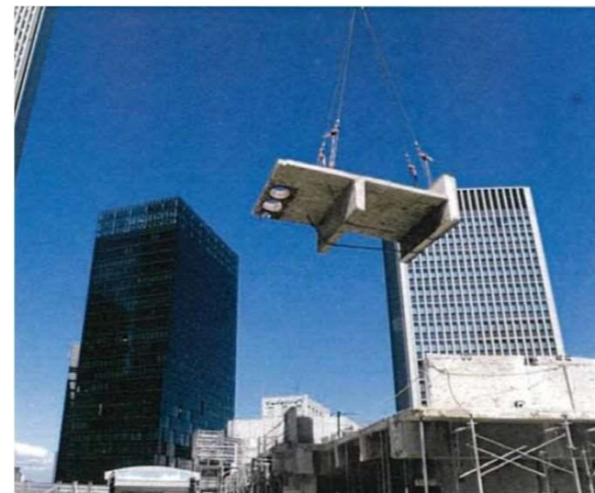
写-7.2.1 ワイヤーソーによるブロック解体揚重作業例
