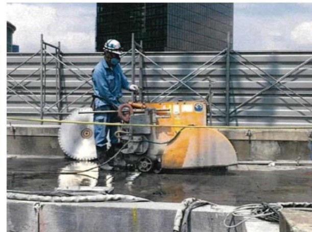
写-7.2.2 ウォールソーによる切断状況例
