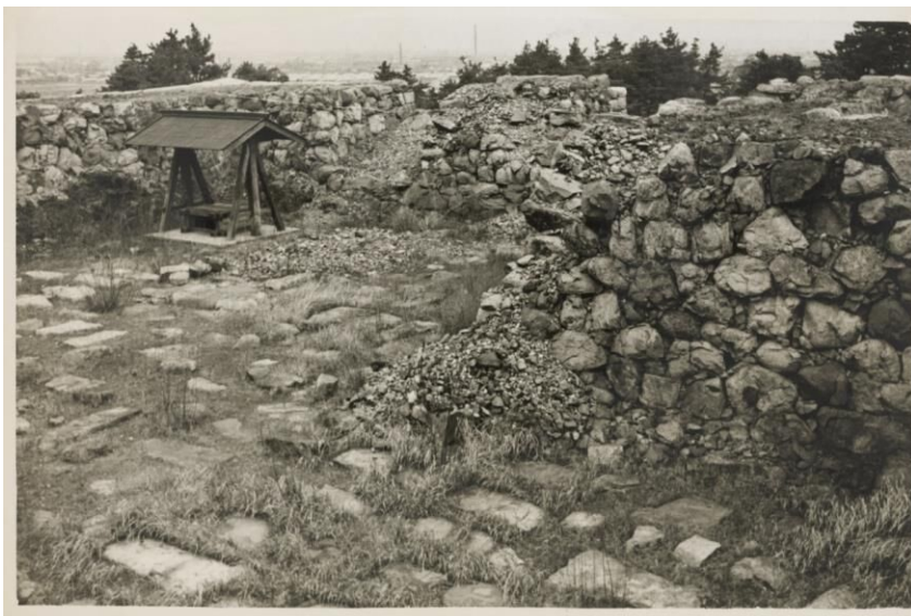
大天守入口から東方向を見る 櫛形、開口部周りの角に崩壊している部分がある
