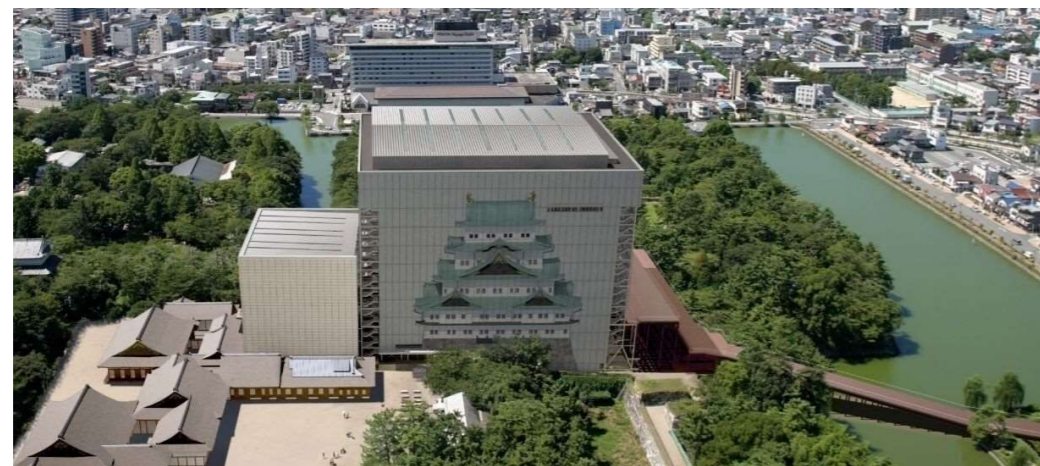
図-7.1.14 素屋根置完了イメージパース
