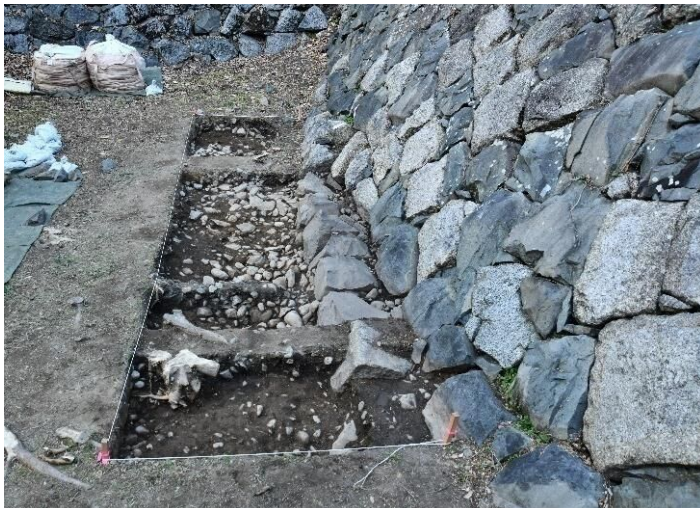
図 12 S10 鵜の首水堀側石垣
