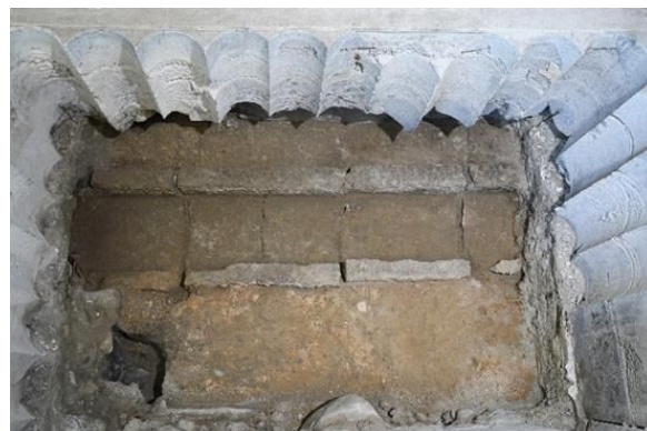
図 16 大天守地階床面の石樋
