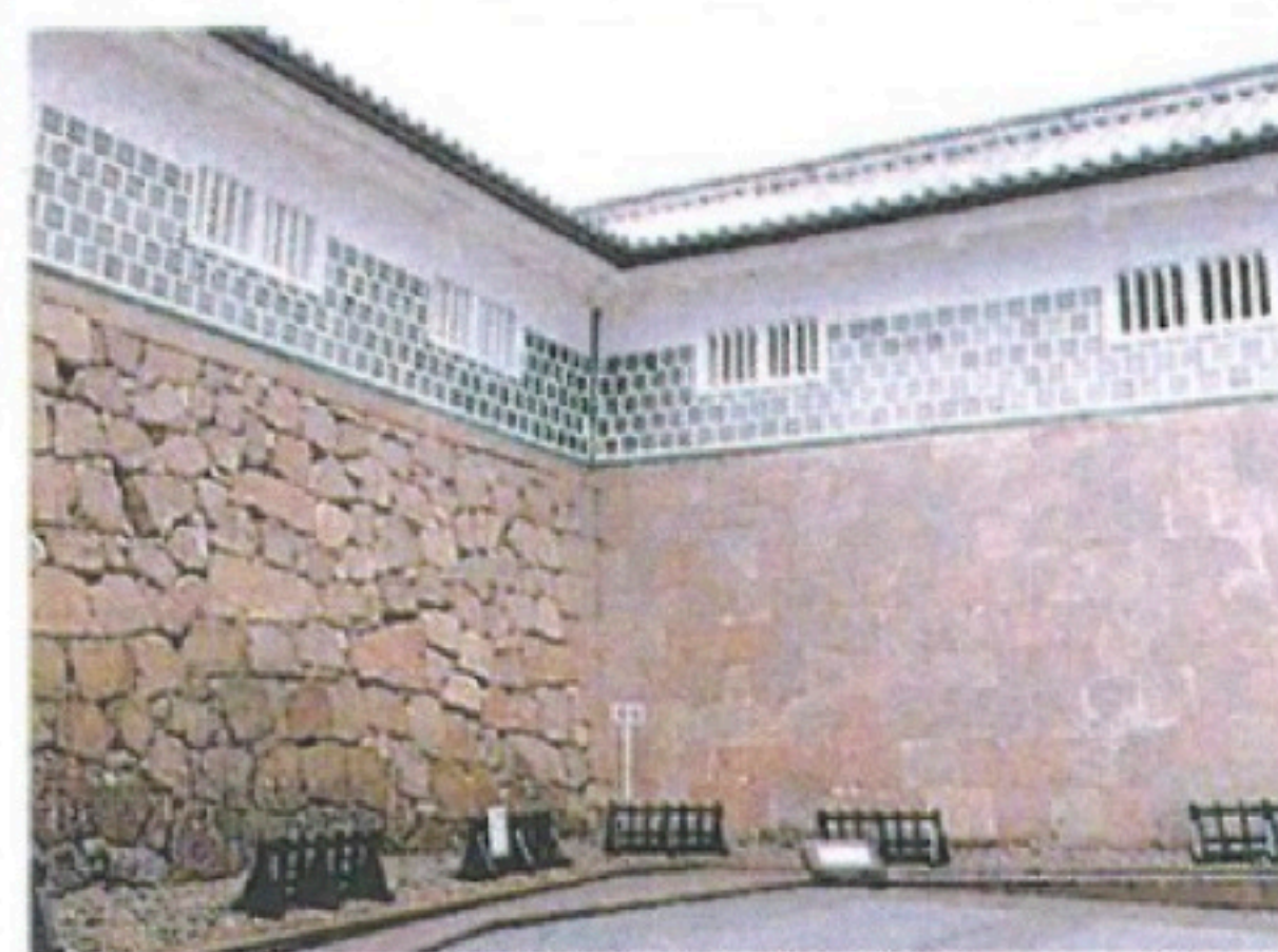
写真左上から時計回り 犬山城天守最上階の壁に取り付けられた花頭窓の枠、信長が築いた安土城の大手道、切込接と打込接の石垣が見られる金沢城石川門、鹿兒島城の石垣で見られる隅欠
