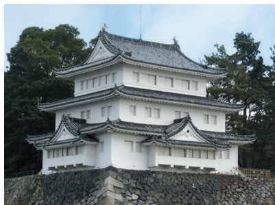
せいほくすみやぐら きよす やぐら じゅうようぶん かざい 西北隅櫓(清須櫓)(重要文化財)
