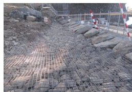
せこう ジオグリッド施工
