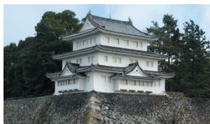
せいほくすみやぐら じゅうようぶん か ざい 西北隅櫓（重要文化財）
