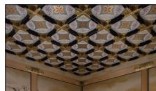
くろしほりかなぐつきごうてんじょう 黒漆塗金具付格天井 (上洛殿)
