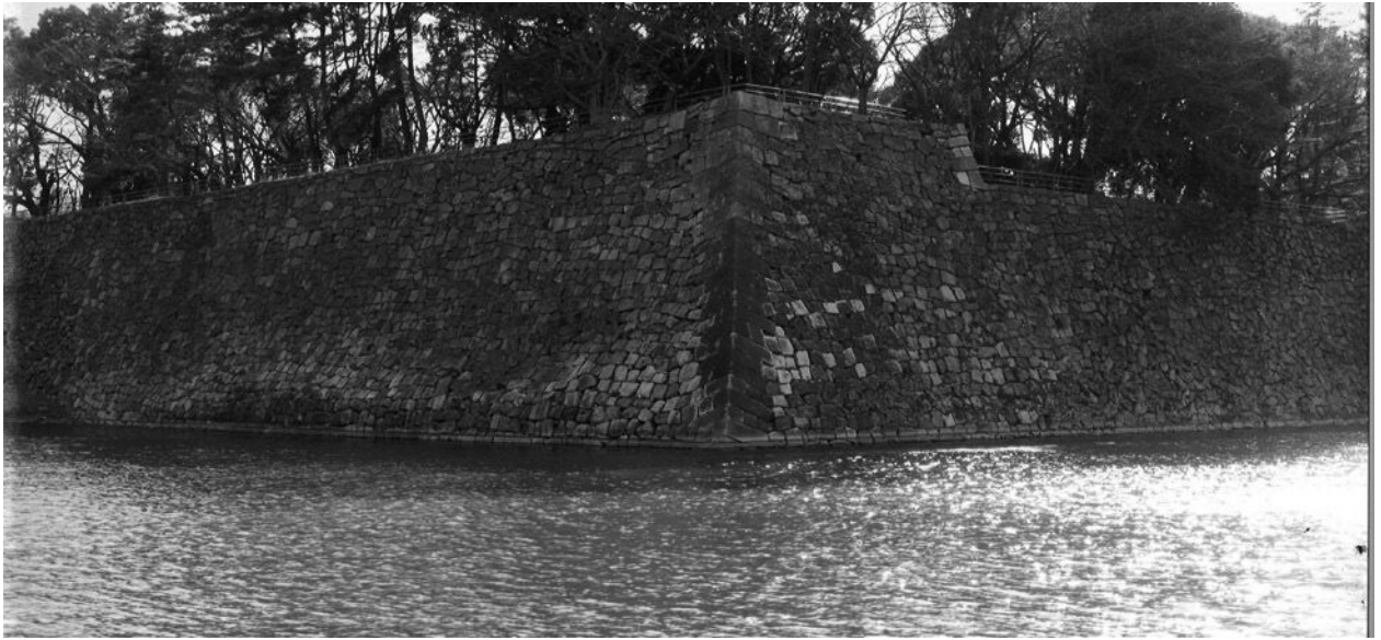
写真1 搦手馬出の石垣全景（北東から）
