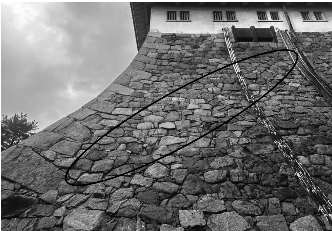
写真 6 天守台南面 (U59) 石垣 修理境界付近
