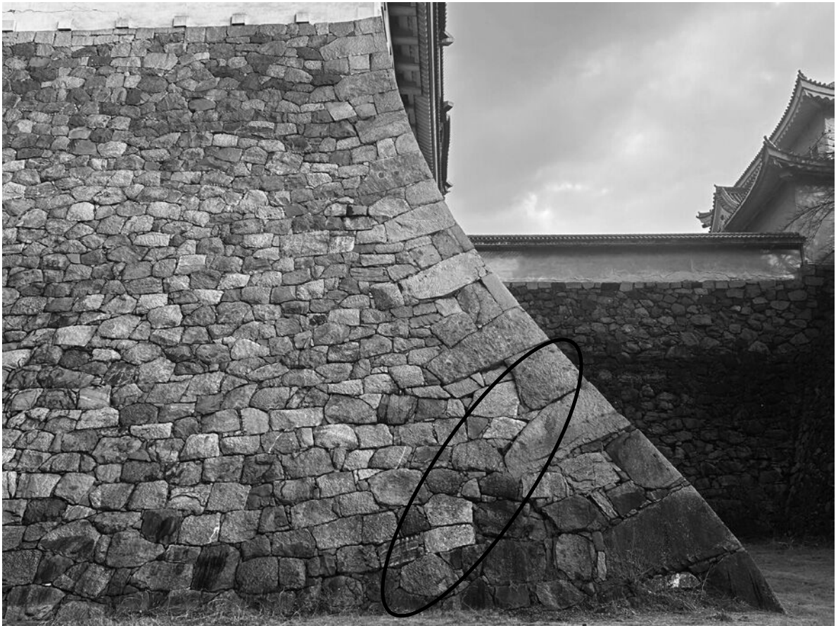
写真 4 天守台西面 (U60) 石垣 修理境界付近
