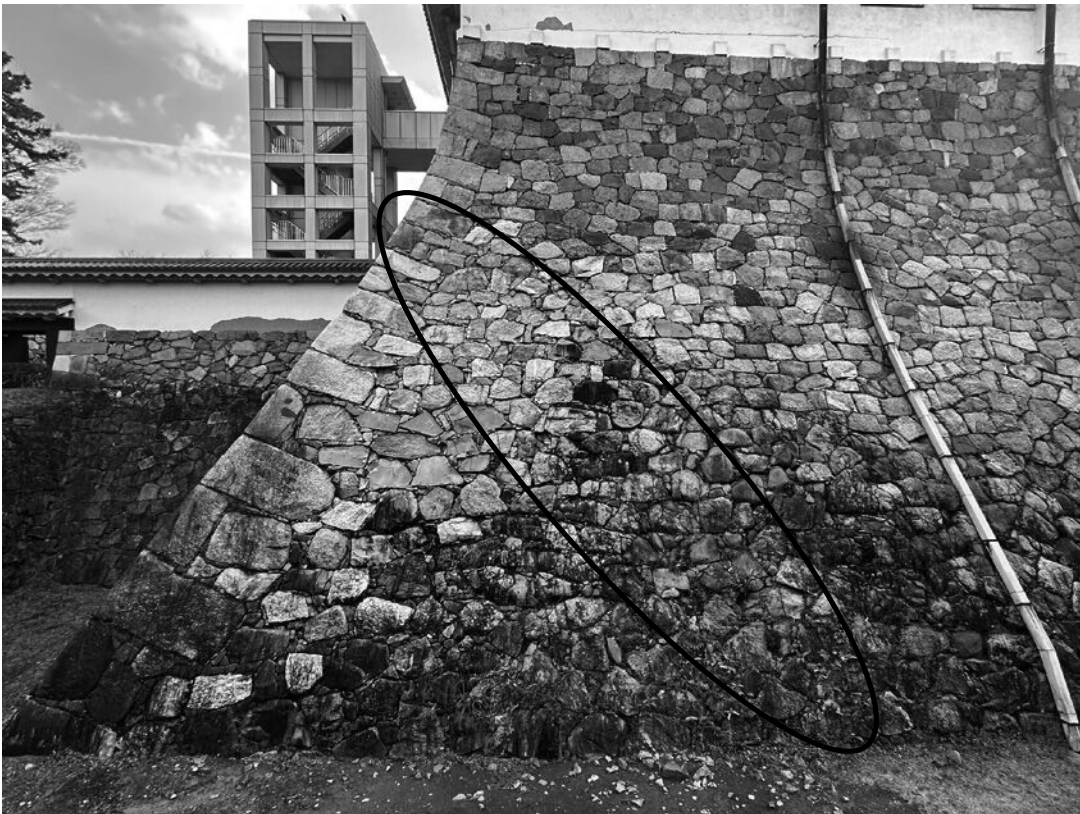
写真 3 天守台北面 (U61) 石垣修理境界部付近
