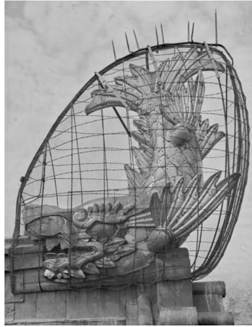
1 名古屋城天守北鯨 ガラス乾板 昭和 12～13 年撮影 名古屋城総合事務所蔵
