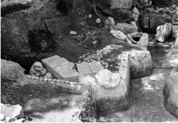
写真24 北園池 東南部掘削状況 東から
