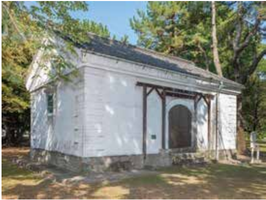
乃木倉庫 外観(南西面)
