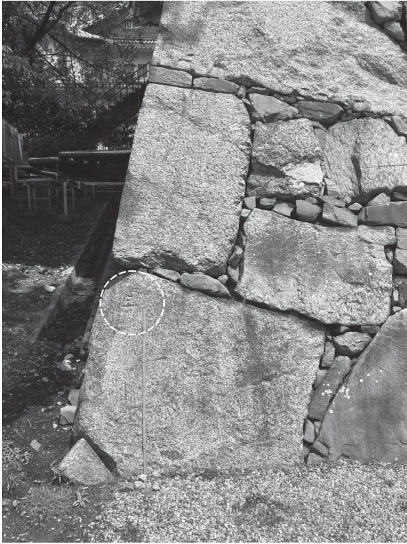
写真3 小天守台南西角／南から
