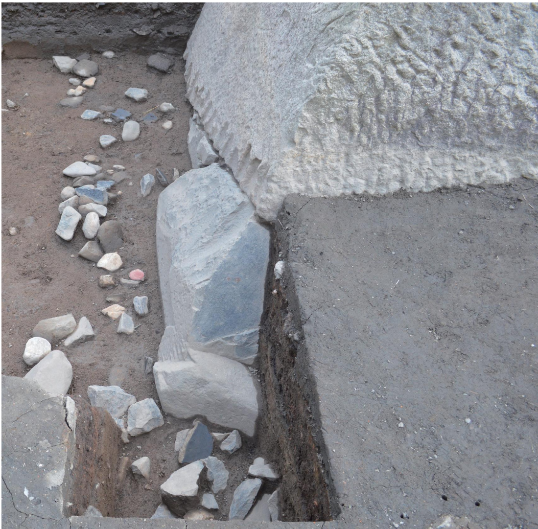
口絵9 天守台石垣 北西隅石下部（西面側から撮影）
