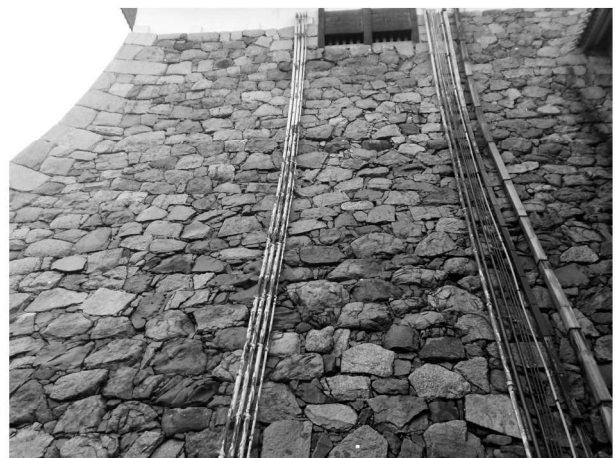
写真3 大天守台南面（U 59）石垣西部
