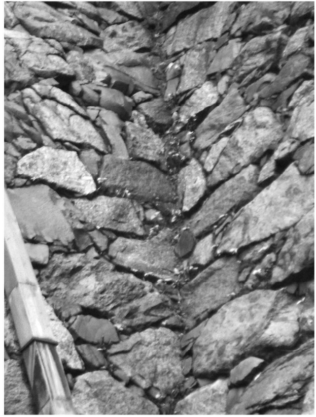
写真8 大天守台南東入隅 (U 59- U 58 間) 上半
