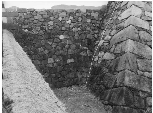
写真2 大天守台東面（U 62）石垣北部
