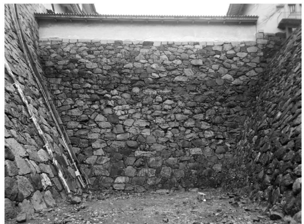
写真5 橋台西面 (U 58) 石垣
