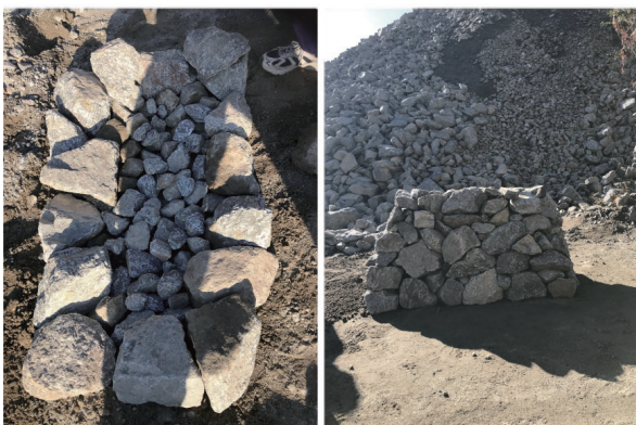
図31 マイ石垣 DIY での石垣1段目と完成石垣
