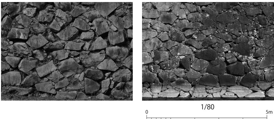
図5 築石部表面の状況（左：前田家（135N石垣）・右：鍋島家（2230石垣））
