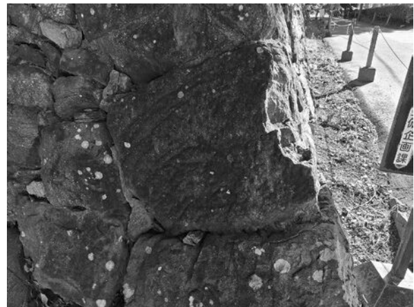
図19 和歌山城勘定門東側石垣角石の表面加工
