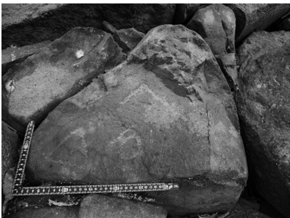
図2 名古屋城跡石垣における美濃帯砂岩築石（左）と和泉砂岩築石（右）
