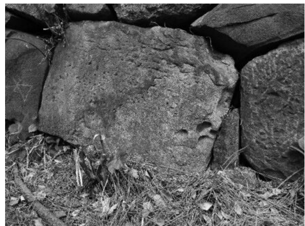
図2 名古屋城跡石垣における美濃帯砂岩築石（左）と和泉砂岩築石（右）
