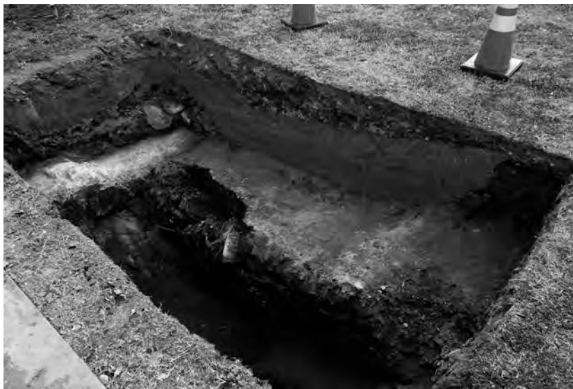
写真10 T-5 完掘 北西から
