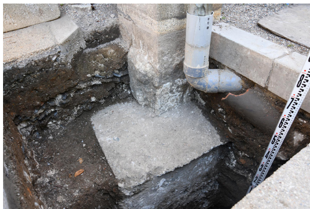
門小屋根控柱の掘削状況（北東から）
