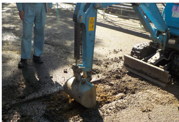
配管工事の掘削状況（北から）
