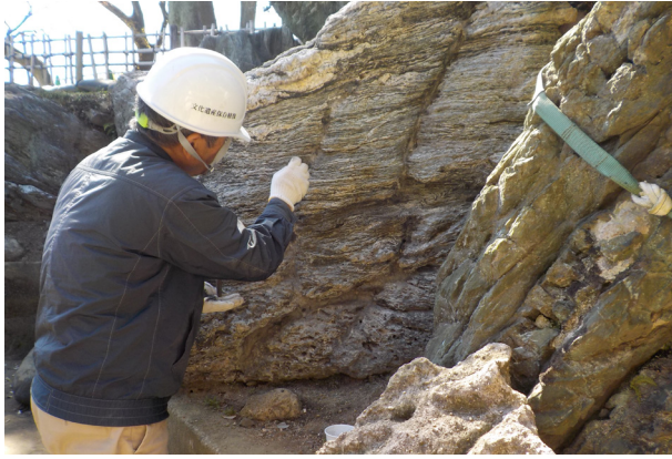
石組の保存修理
