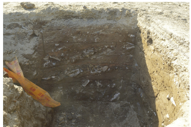
柵の掘削状況
