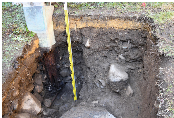
脇塀控柱の掘削状況（東から）
