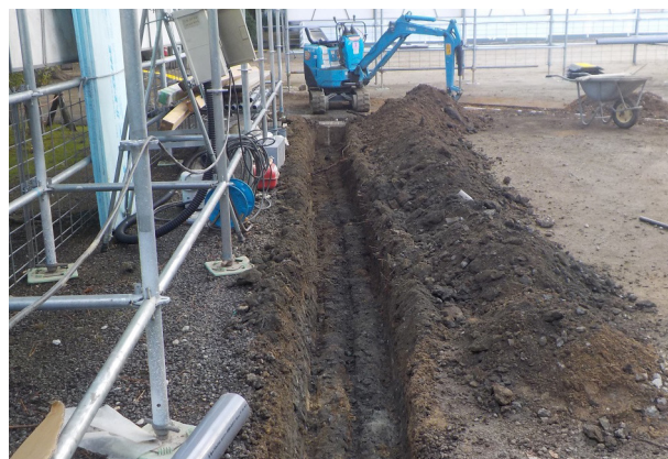
掘削の完了（北から）
