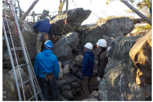
景石の据え直し
