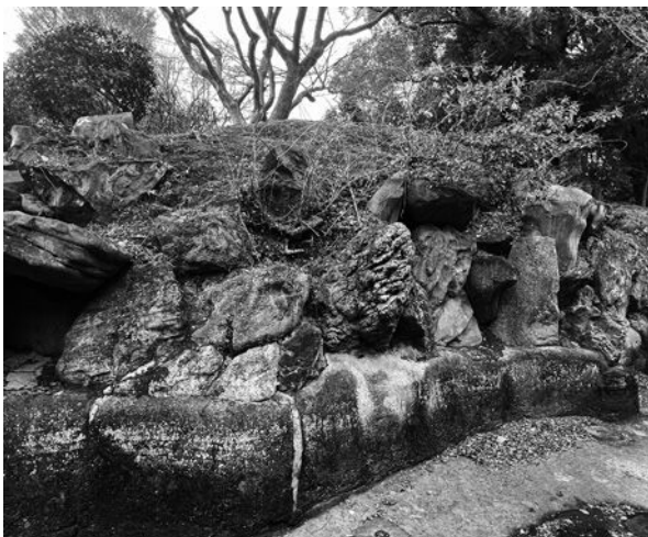
写真1 四ツ代山 北池側（南から）（現況） 下からタタキ製の護岸、石組み
