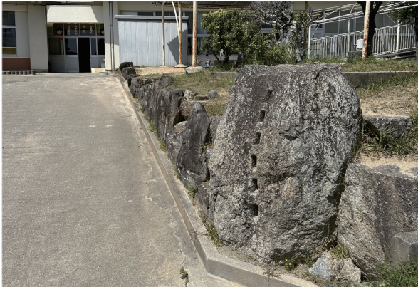
図 29 東幡豆小学校正門門柱の残石
