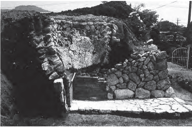
写真 24 西野石灰焼窯址 1号窯 (註 10 より)
