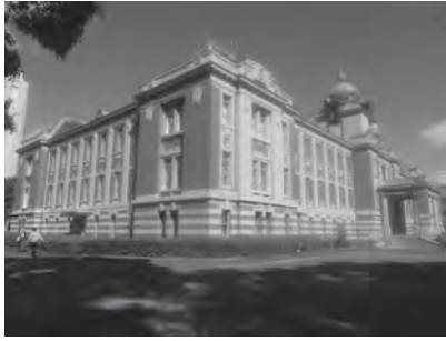
写真 17 旧名古屋控訴院地方裁判所区裁判所（現名古屋市市政資料館）
