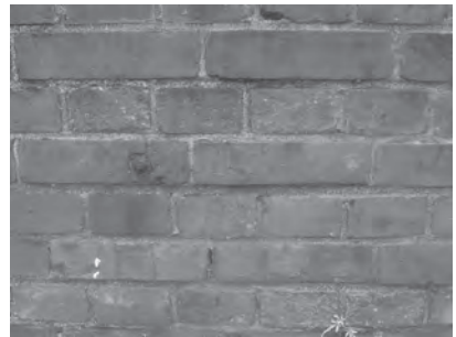
写真10 れんが壁近景
