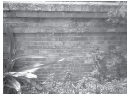
写真13 れんが壁近景
