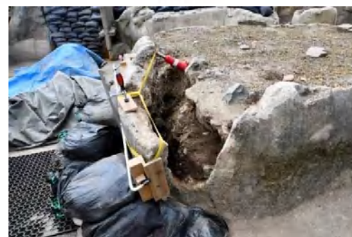
SP6-6' 傾倒護岸 取り外し状況
