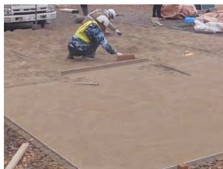
土系舗装の施工
