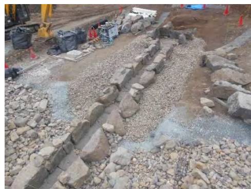
石組暗渠排水溝遺構復元(北西から)
