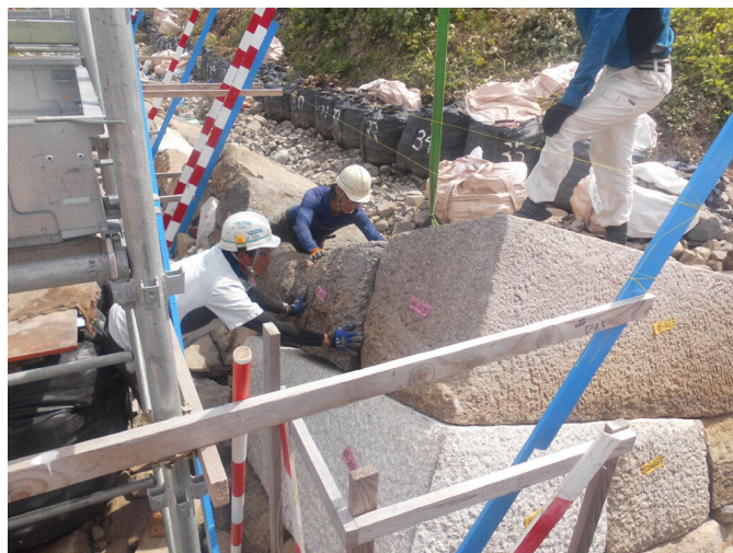
角石積直し作業(下段の白い角石は新補石材)
