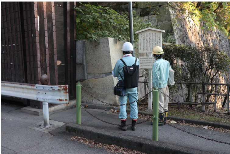
石垣カルテ作業風景（152N石垣）
