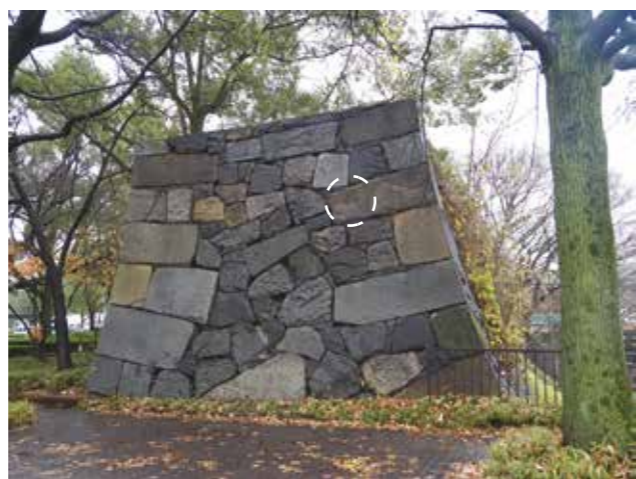
▲写真1 御園門跡付近の石垣(白丸内「進上」の刻字あり)
